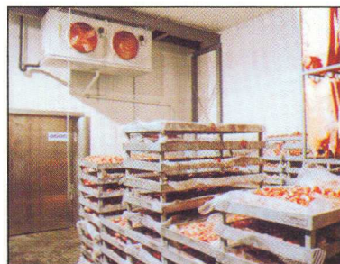
In alto, la sede dell'azienda di Parma. A lato, una cella di conservazione a -25 gradi. In basso da sinistra, il processo di raffreddamento rapido e ancora una fase di conservazione a bassissima temperatura
